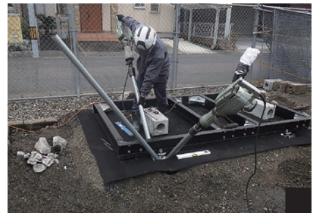
4本の鋼管を電動工具にて 地中へ打込む
