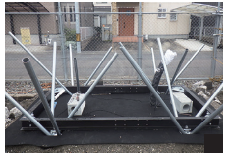
BGF基礎を配置し、 フレームを取り付ける
