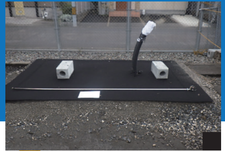
キュービクルを設置する 場所を確認
